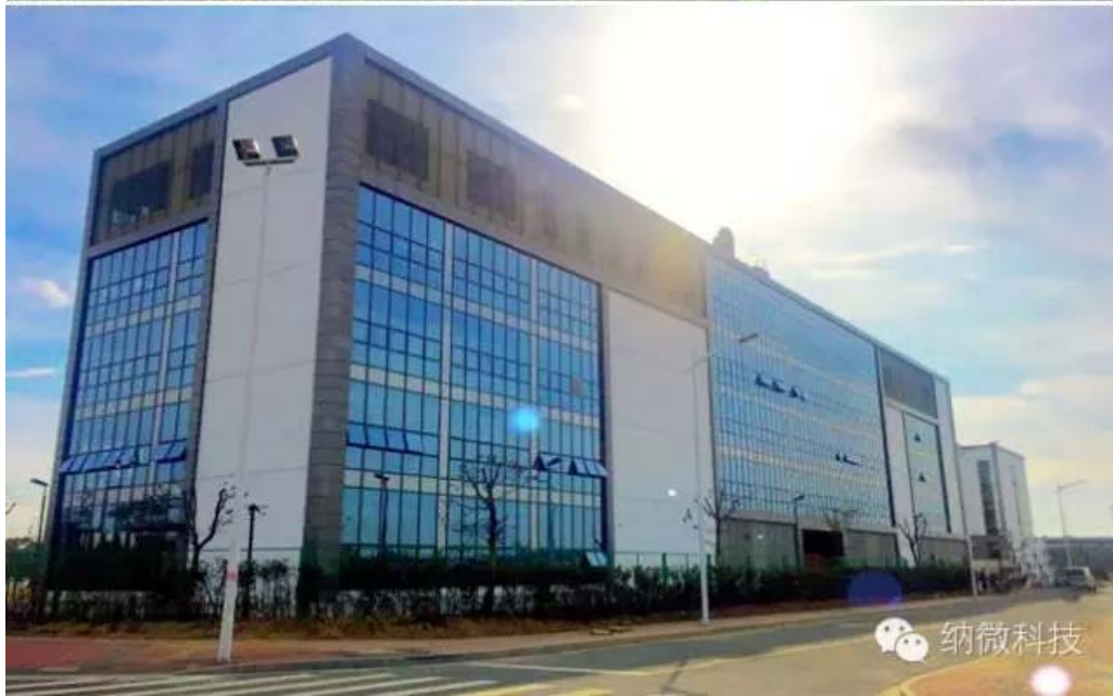
納微新建現代化研發中心和生產基地
